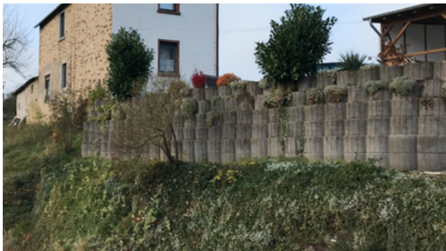
Negativ: Stützmauer aus Betonsteinen
