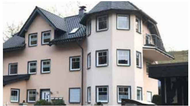
Gestalterische Disharmonie, Turm wirkt überdimensioniert
