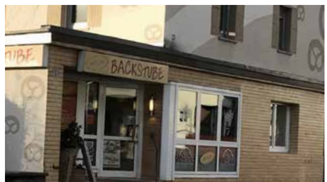
Negativ: Schaufenster berücksichtigt nicht die Gliederung der Fassade
