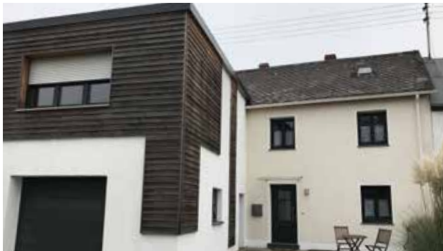
Gestalterische Disharmonie zwischen Hauptgebäude und Anbau
