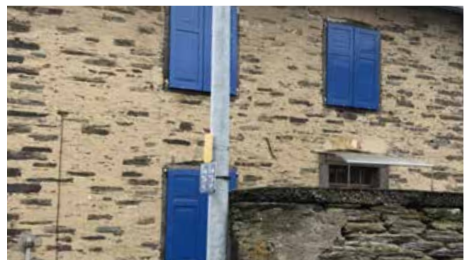
aufdringliche Farbgebung (Fensterrahmen, Klappläden)
