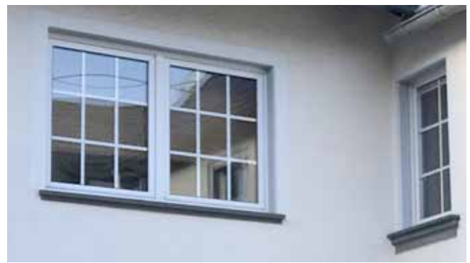
Negativ: aufgeklebte Fenstersprossen
