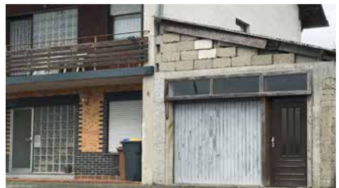
Negativ: angebauter Carport ohne Bezug zum Hauptgebäude
