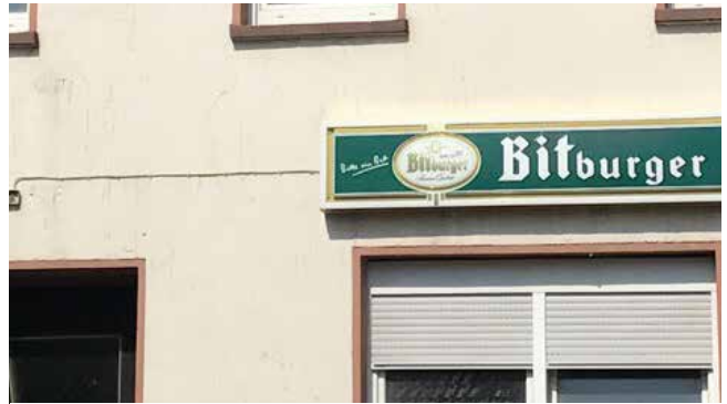
Negativ: Werbeanlagen mit offenliegenden Kabeln
