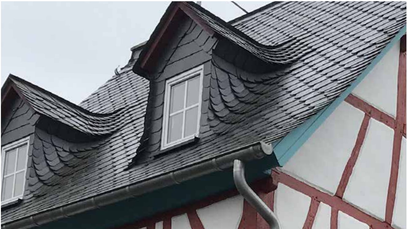
Positiv: Saniertes Fachwerkhaus mit Schiefereindeckung und Satteldachgauben (ortstypisch)
