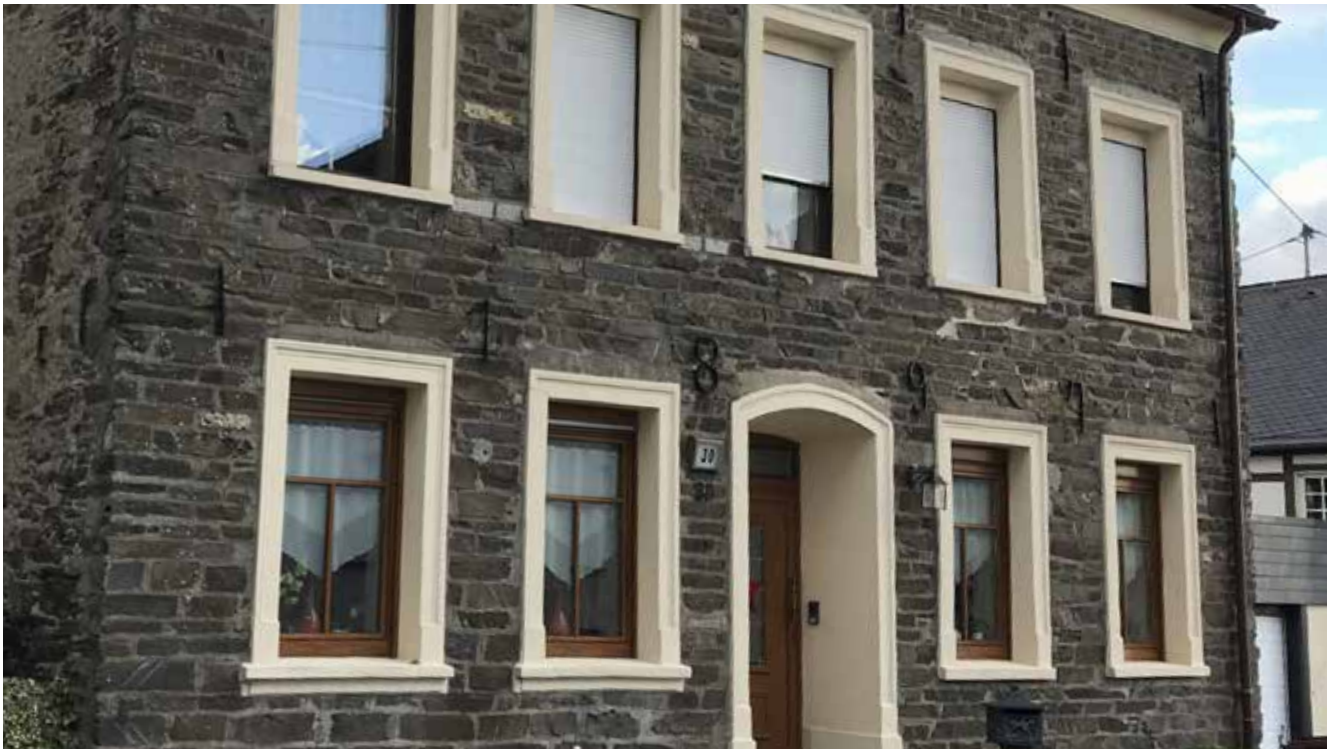
Positiv: auf Bestand abgestimmte Fensterelemente
