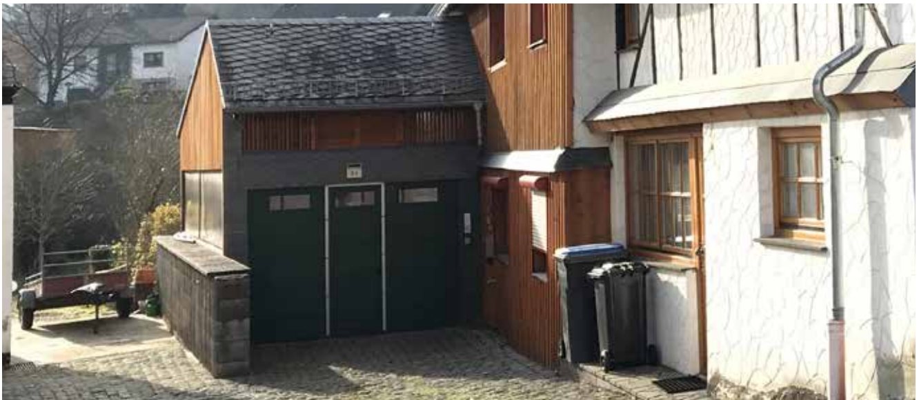
Positiv: Hauptgebäude und Carport bilden eine Einheit
