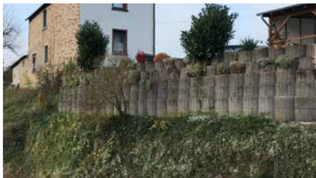
Negativ: Stützmauer aus Betonsteinen
