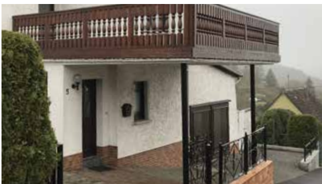
Negativ: im Vergleich zum Hauptgebäude überdimensionierter Balkon
