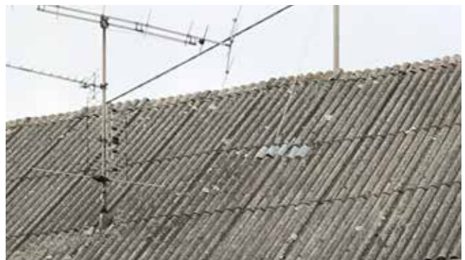
Negativ: Dacheindeckung aus Eternit
