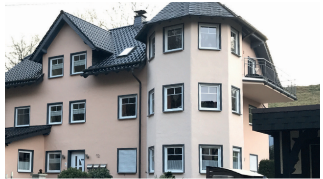
Gestalterische Disharmonie, Turm wirkt überdimensioniert
