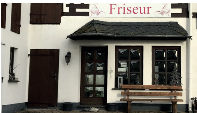
Positiv: Schaufensterelemente sind an die Fassade angepasst
