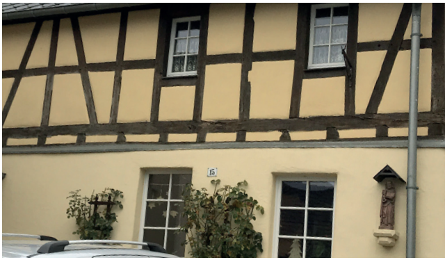
Positiv: renovierte Fachwerkfassade
