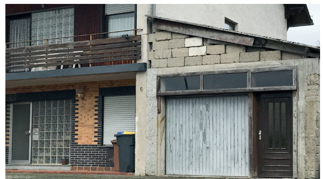
Negativ: angebauter Carport ohne Bezug zum Hauptgebäude
