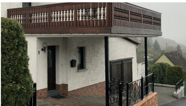
Negativ: im Vergleich zum Hauptgebäude überdimensionierter Balkon
