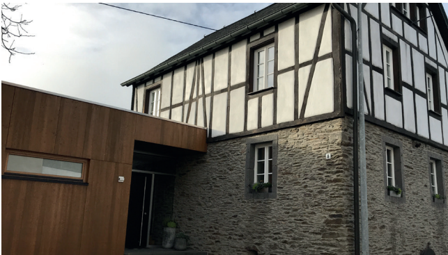
Diskrepanz zwischen Hauptgebäude und Anbau (in puncto Dachform, Material, Farbgebung)
