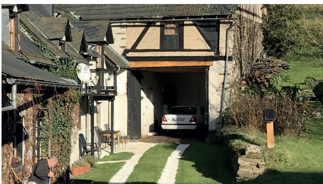
Positiv: Hauptgebäude und Carport bilden eine Einheit, wasserdurchlässige Zufahrt
