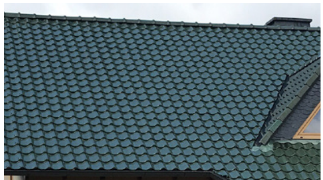
Negativ: Dacheindeckung mit glasierten grünen Ziegeln
