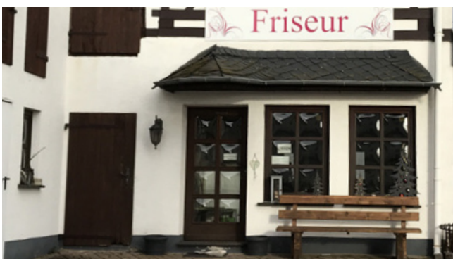
Positiv: Schaufensterelemente sind an die Fassade angepasst
