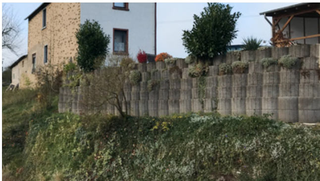
Negativ: Stützmauer aus Betonsteinen
